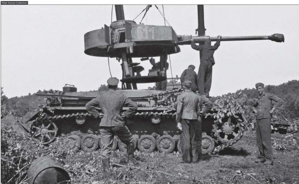
A daruval felemelt toronynak köszönhetően jól látszik a toronykosár. A toronnyal együtt forgó küzdőtér jelentős előrelépést jelentett a háború kezdetekor használt, kevésbé jól megtervezett elődökhöz képest. A szabadon látható belsón megfigyelhető egy apró érdekesség: a kosár jobb oldali tartólábára erősített doboz, amely a tartalék géppuskacsövet rejtette magában. Ez bármilyen más szögből nézve rejtve marad. A "611"-es lövegcsövének végén pár győzelmi gyűrűt is láthatunk.
